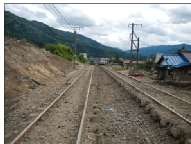
写真-2 流入物撤去状況
