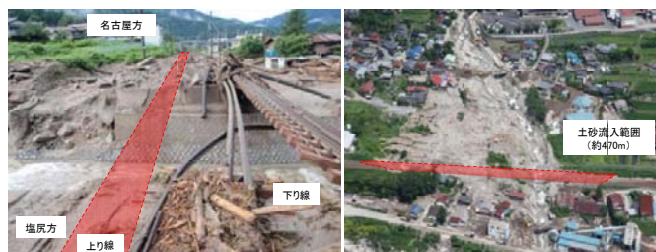
写真-1 土石流被災状況
