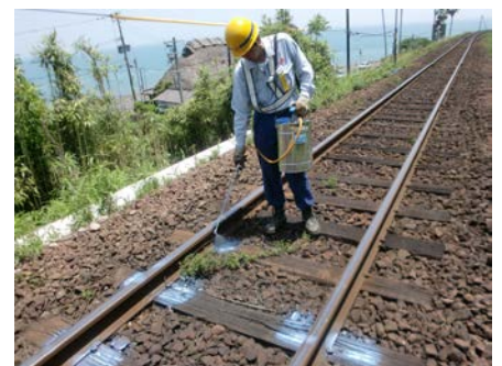
写真-1 防火塗料塗布
