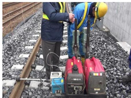
写真1 二頭式ボルト緊解機全景
