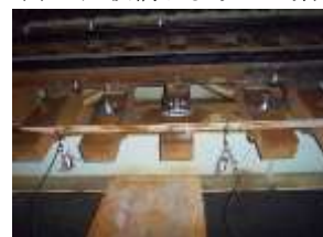
(b) フックボルト軸力の測定状況
