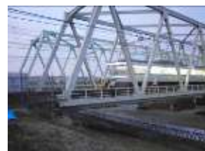
(a) 試験橋りょうの全景
