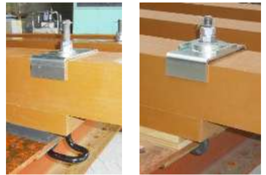
(a) 線ばねフックボルト (b) Vばね緩衝フックボルト
