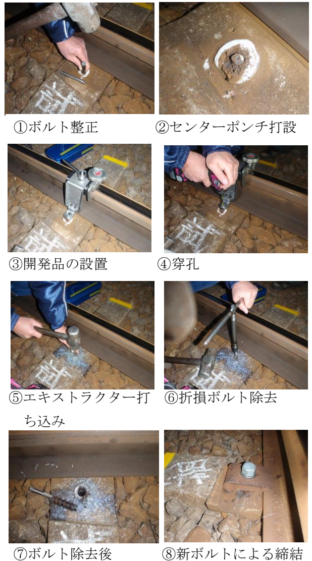
図-3 開発品での作業手順
