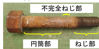
(b) アンカーボルト (敷設後 10 年程度)
