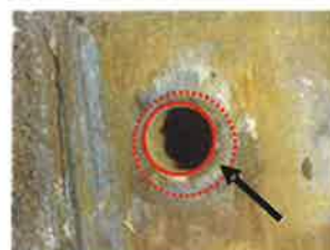
旧削孔径 \phi 24\text{mm}
