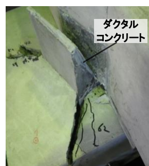
写真-2 ダクトル
