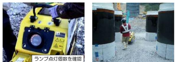
写真-2 バイプロコンパクター転圧状況
