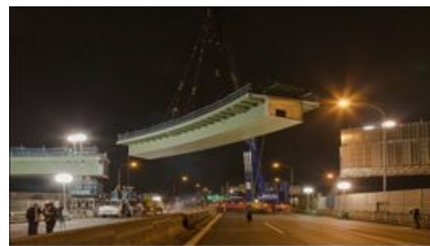
写真-2 550t オールテレーンクレーンによる架設状況
