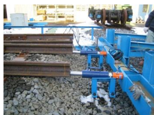
図6 荷重載荷状況
