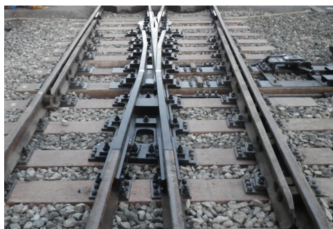
図8 敷設後の新型ノーズ可動クロッシング
