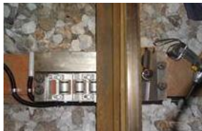
図 1 ローラー床板の試験敷設
