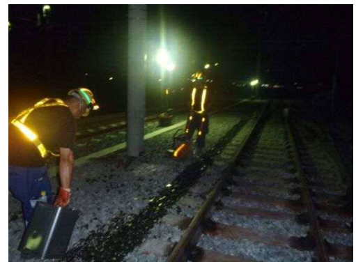
写真 4 締め固め・道床固結剤散布
