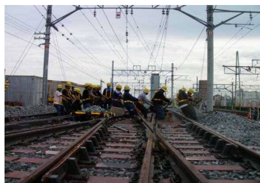
写真 2 通り整正作業
