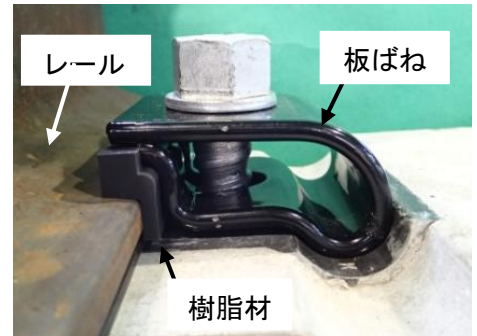
図4 レール締結装置の概要
