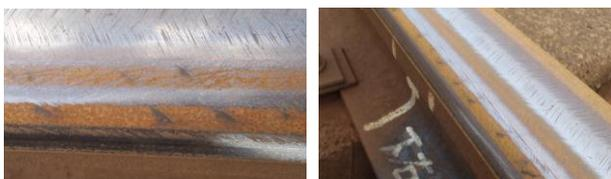
図-1 曲線区間におけるレール削正（現状）
