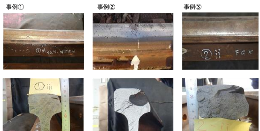
図4 横裂検知箇所のレール破断面の事例
