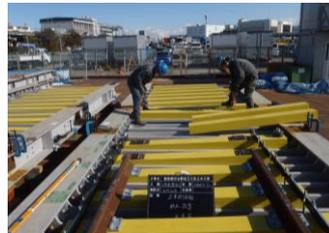
写真-3 工事桁仮組
