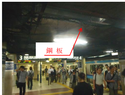
写真・3 鋼板を取付けた構内状況
