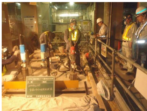
写真・2 乾式コア削孔状況
