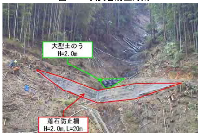
写真-3 土石流対策
