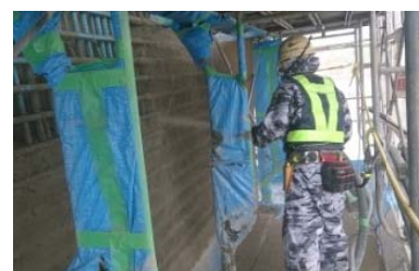
写真-4 吹付状況
