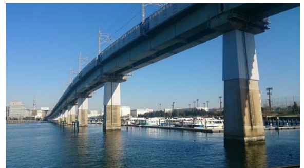
写真-1 現場全景（補強後）
