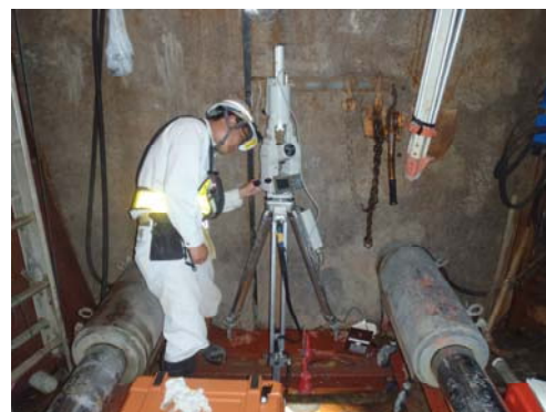
図－5 ジャイロ測量実施状況
