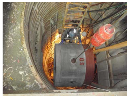
図－4 推進管投入状
