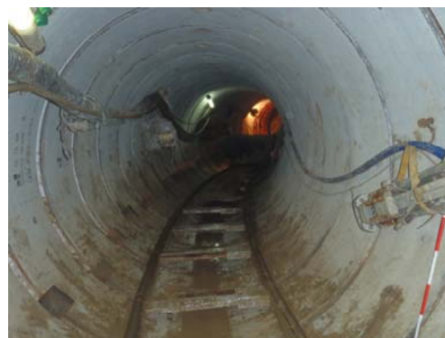
図－6 曲線区間施工状況
