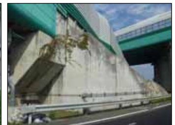
図-5 DA1 橋脚部・擁壁部
