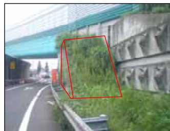
図-4 DA1 擁壁部
