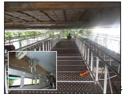
写真-3 ラック足場上
