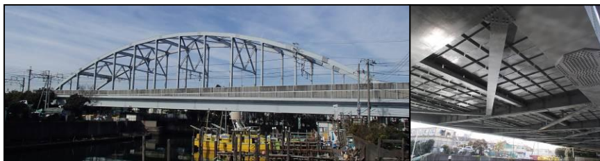
写真-1 橋りょう全景と床組構造 (右写真)
