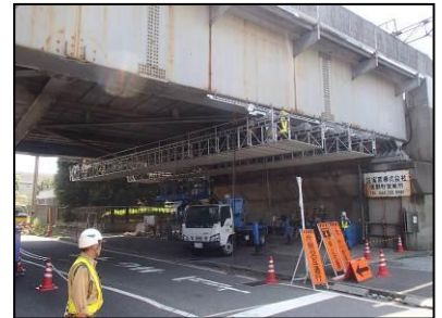
写真-2 足場組立状況
