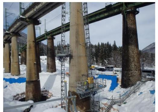
図-4 円錐形昇降式足場の施工状況
