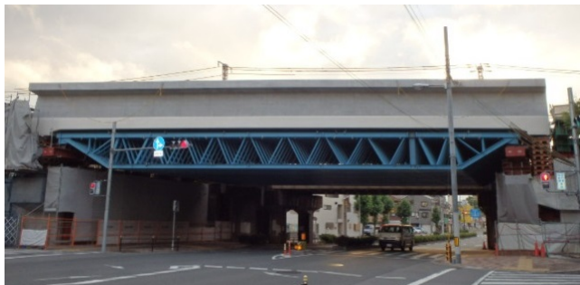
写真-3 施工状況（コンクリート打設完了）
