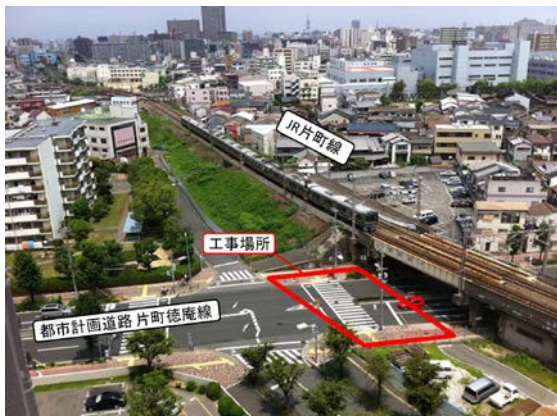
写真-1 施工位置
