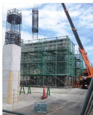
写真-2 柱ユニット化施工状況
