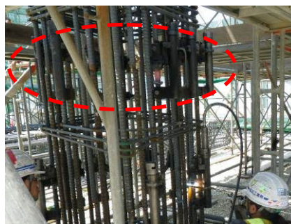
写真-1 ユニット鉄筋圧接状況
