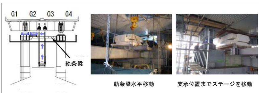
図-5 ⑤新設支承の軌条梁水平移動
