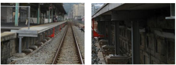
(写真-1) 施工完了(左: 全景 右: A区間詳細)
