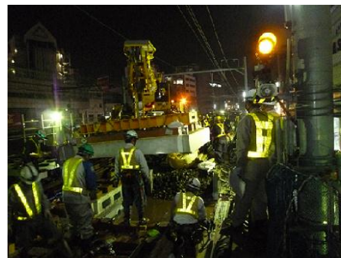
写真-1 コンクリート路盤架設状況
