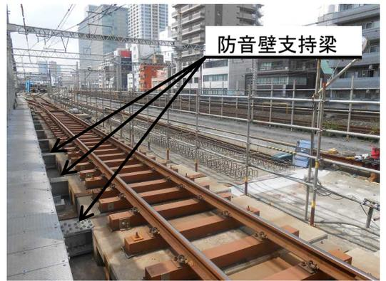
写真-2 路盤コンクリートと防音壁支持梁
