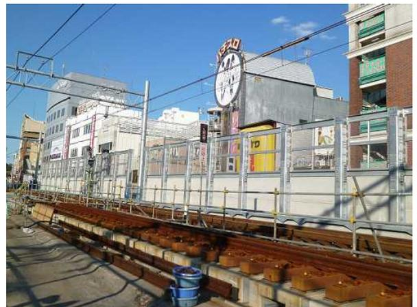
写真-1 防音壁 (h=4m)
