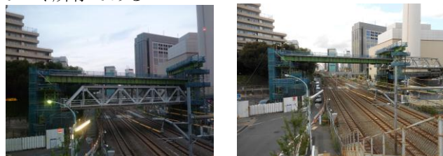
(a) 撤去前 (b) 撤去後 図-7 トラス橋りょう撤去前後
