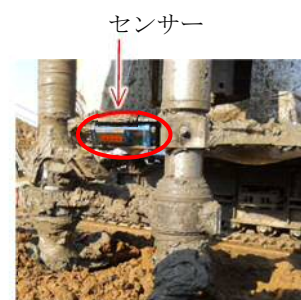
図-5 センサー設置状況
