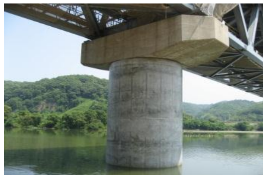
写真-1 RC 巻立て補強
