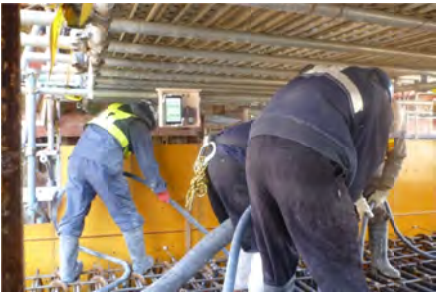
写真-1 測定状況
