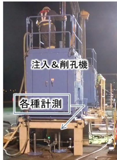
写真-2 施工機械 (機械架台下にて計測)
