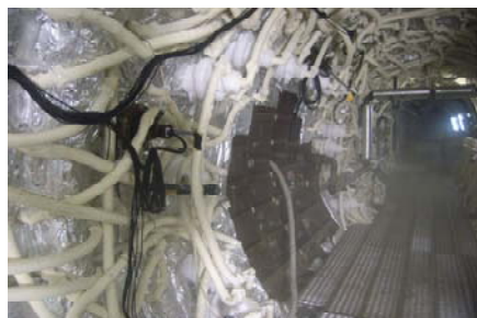
写真-1 共同溝側開口部凍結運転状況
