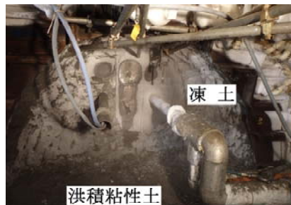
写真-2 横坑掘削状況
