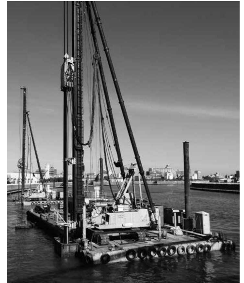
写真-1 施工状況
