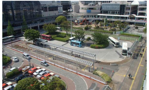
写真-1 工事箇所の全景
