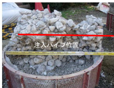
写真-2 出来形縦断
