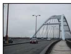
写真1 管理区分1の橋梁の1例
