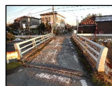
写真2 管理区分4の橋梁の1例
