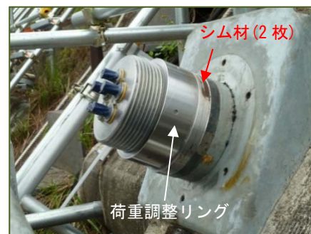
写真-2 アンカーヘッド部
