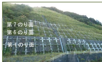
写真-1 のり面全景
