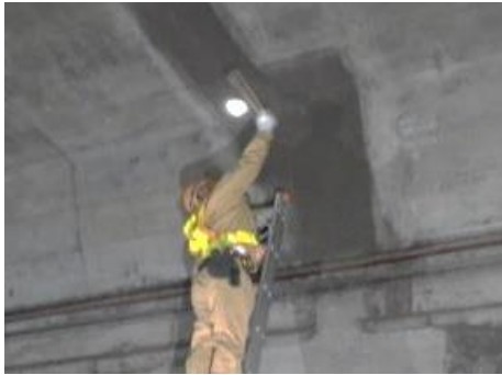
写真-1 断面修復箇所打音点検状況
