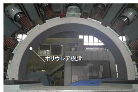
図-3 吹付け後の試験体
