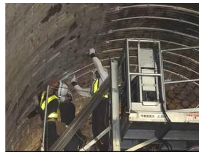
パネル設置状況(肩部)
