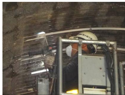
アンカーにて定着状況
