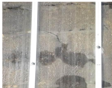
設置後の覆工表面状況
