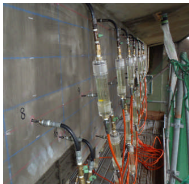
写真-1 施工状況
