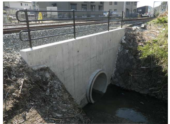
図-7 施工後上流方全景
