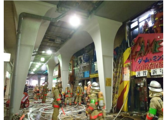
写真－1 火災状況
