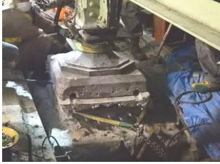
写真-4 沓座御影石撤去
