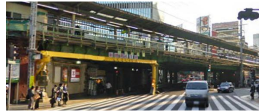
写真-1 架道橋全景
