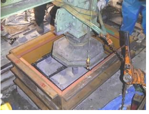
写真-5 鉄筋・型枠組立
