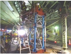
写真-3 ベント組立
