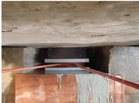
写真3 フラットジャッキ設置状況
