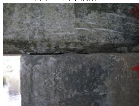
写真 2 桁据付け状況
