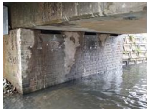
写真5 施工完了状況（起点側）
